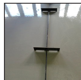
Ook tijdens het gieten blijven de profiel strak en hun positie behouden.
