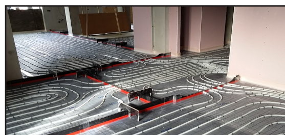
Antikantelsteunen geplaatst voor het gieten.
