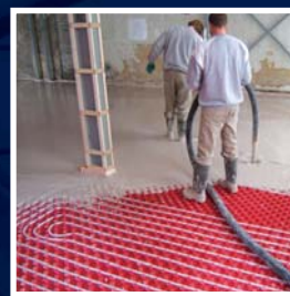
Gieten van Gyflon anhydrietmortel.
